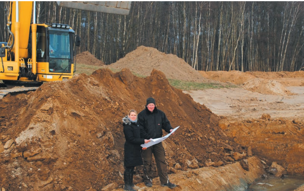
Bettina Gebhard, Dezernentin für Naturschutz und Entwicklung im Biosphärenreservatsamt und Herr Baumann von der MTS GmbH aus Demmin auf der Baustelle.
