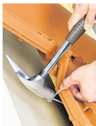
Das Anbringen der Sturmklammern ist vom Fachmann schnell erledigt. FOTO: EPR/FOS
